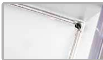
Caleira dreno da água Internal drain channel
